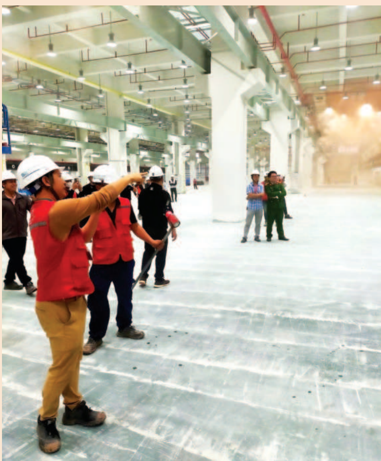
Công ty phối hợp với cán bộ công an nghiệm thu hệ thống PCCC
