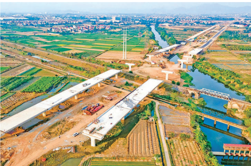
Dự án Đường Vành đai 4 – Vùng Thủ đô Hà Nội có tổng chiều dài 112,8km, đi qua Bắc Ninh (36,26km)
