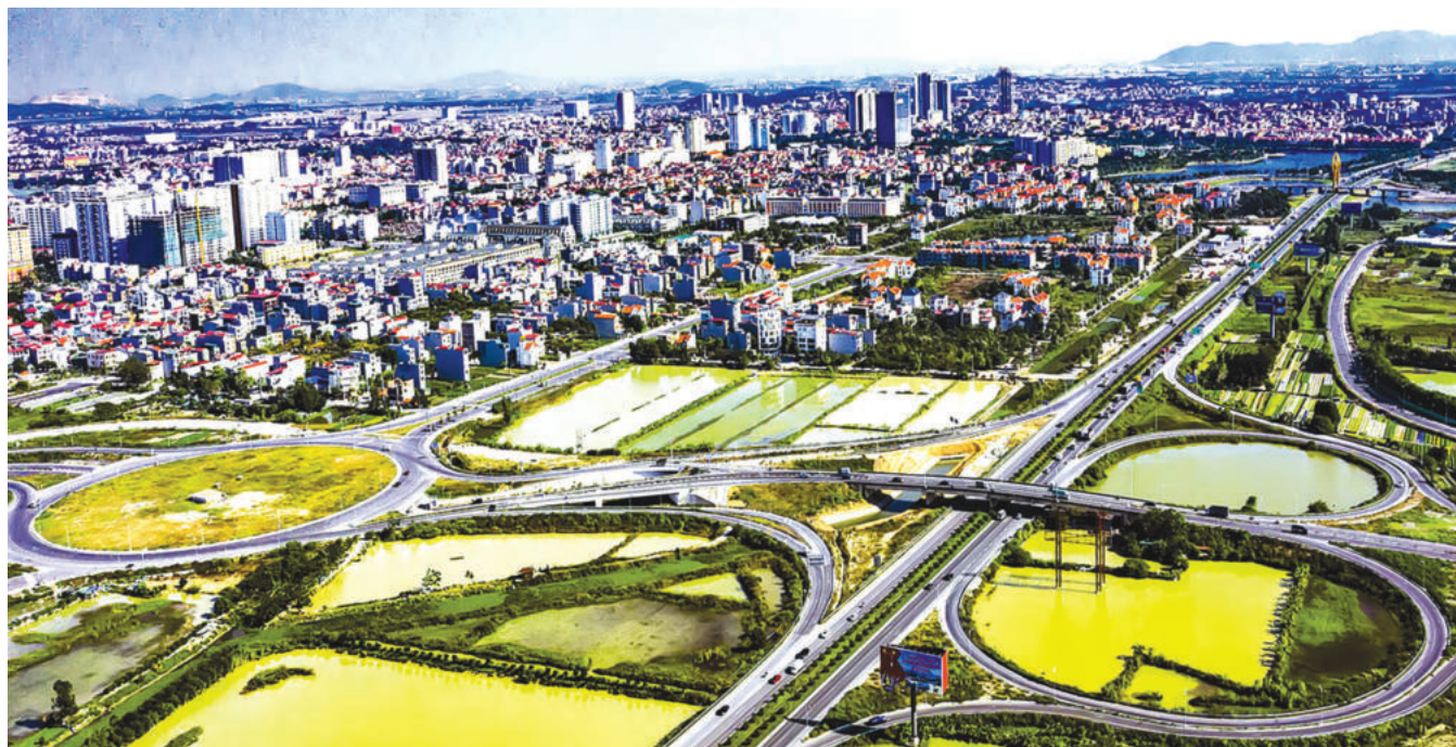
Nút giao thông phía Tây Nam thành phố Bắc Ninh được xây dựng đồng bộ, hiện đại, tăng tính kết nối
