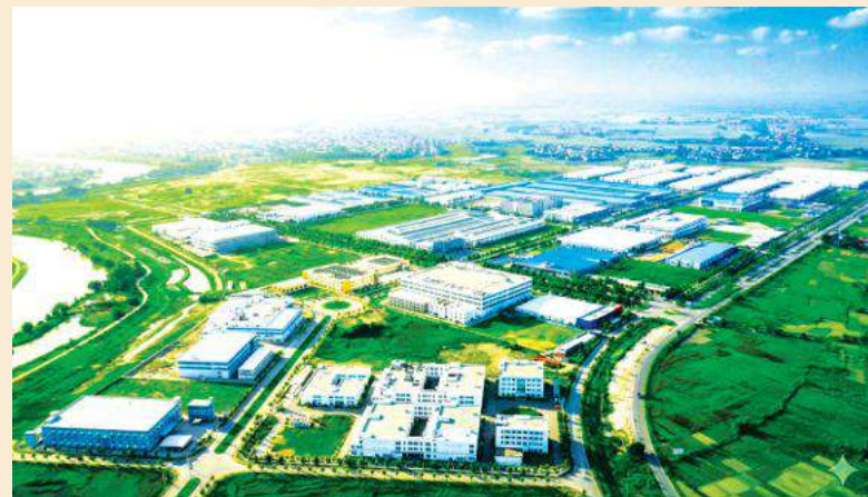
Một góc hạ tầng hiện đại tại KCN Hòa Phú, nơi góp phần thu hút hàng chục nhà đầu tư thứ cấp và tạo việc làm cho hàng nghìn lao động địa phương
