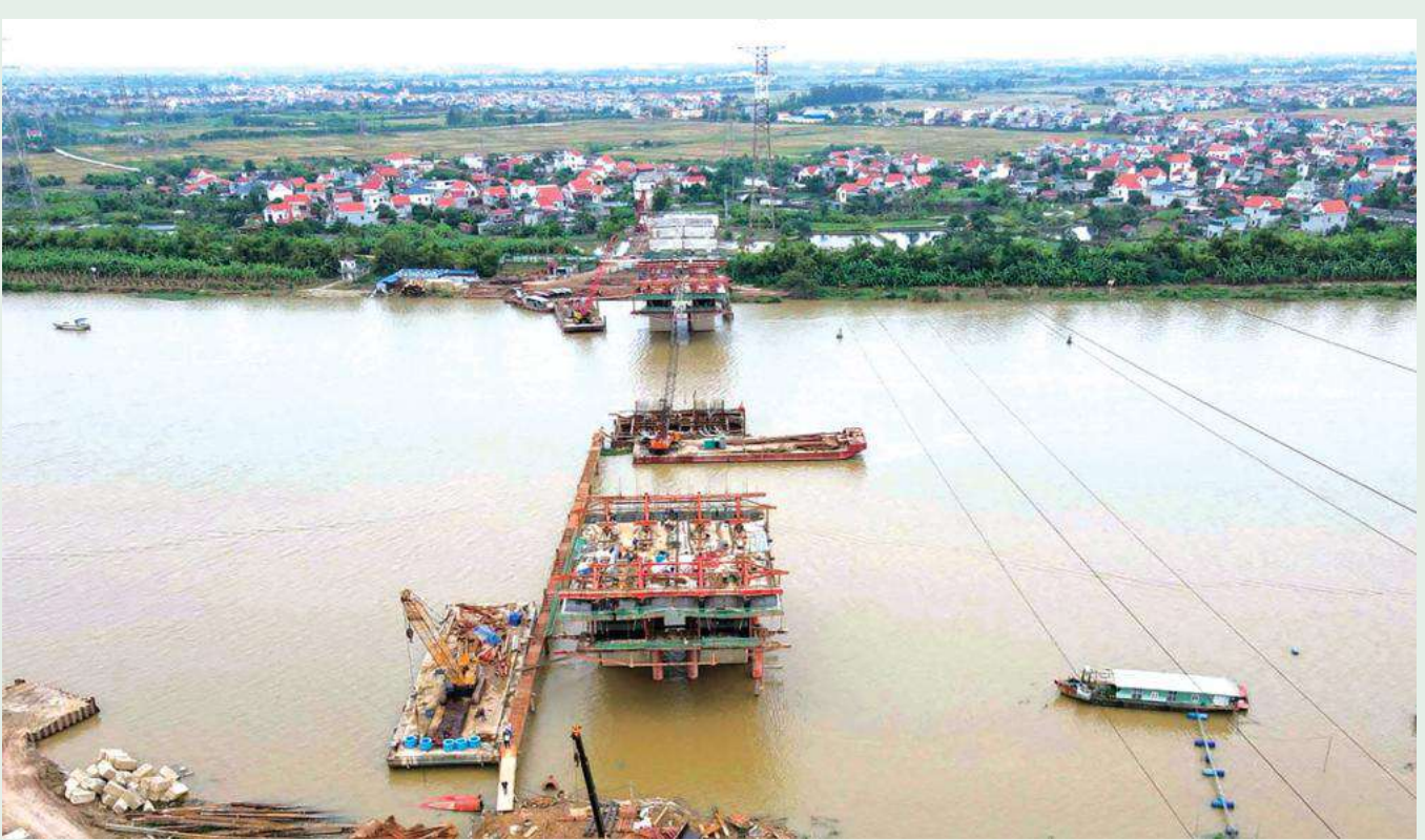
Dự án cầu Kênh Vàng - “mắt xích” quan trọng kết nối Bắc Ninh - Hải Phòng đang được tập trung nhân lực, máy móc để đẩy nhanh thi công
