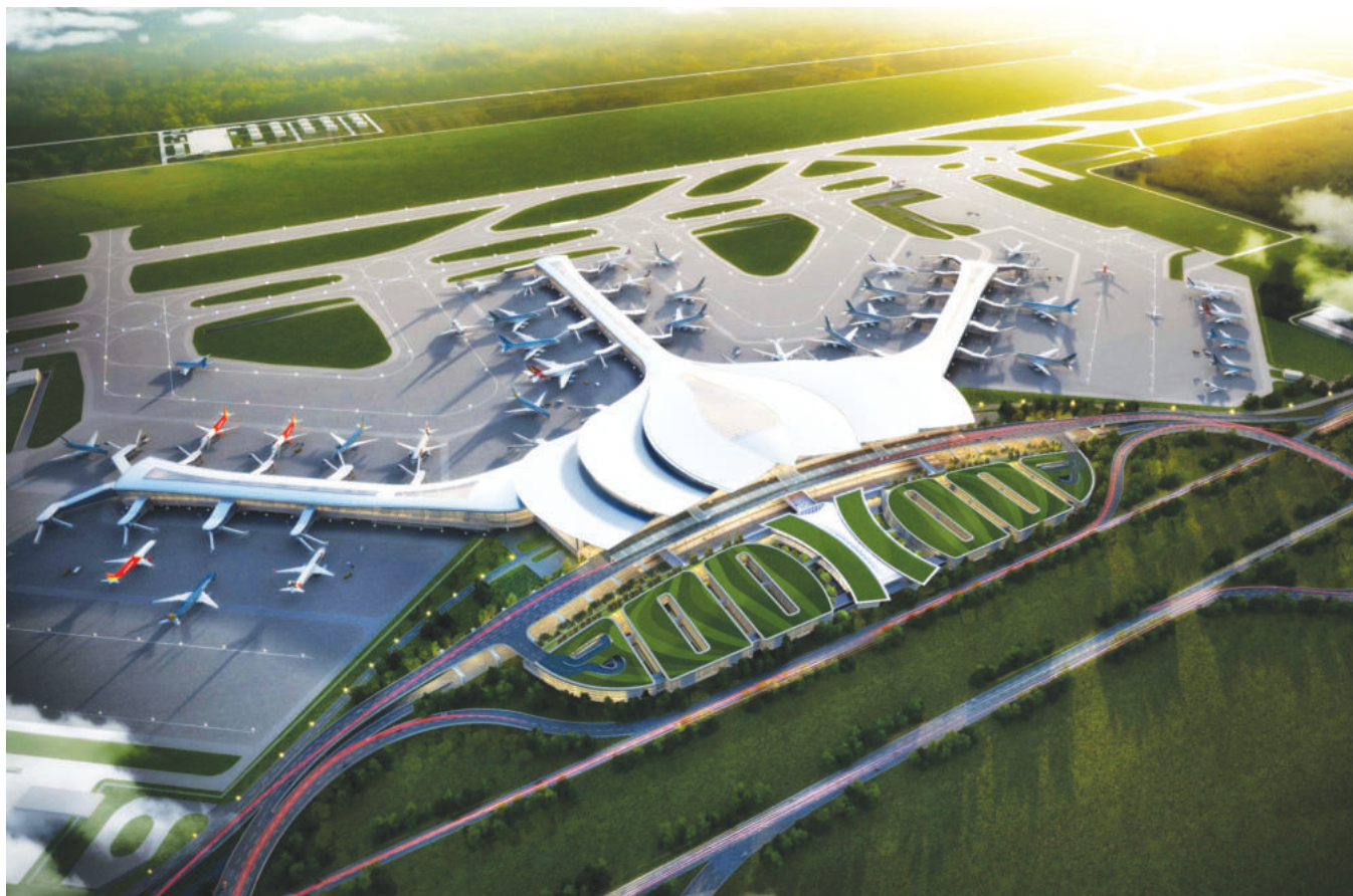
Sân bay Long Thành là một trong những dự án hạ tầng quan trọng của Việt Nam và được kỳ vọng trở thành trung tâm trung chuyển hàng không lớn nhất trong khu vực
